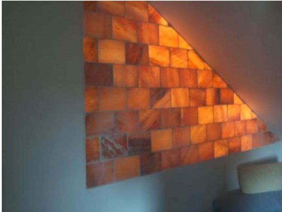
Im Prinzip wird hierbei genauso gemauert wie mit dem Natursteinkleber. Der Fliesenkleber ist aber etwas heller und das Fugenbild entsprechend weiß-gräulicher. Aber ansonsten gelten die gleichen Anwendungs- bzw. Verarbeitungshinweise wie beim Natursteinkleber. Gut bei beiden Kleber ist, daß man Höhenversetzte gut ausgleichen kann.
