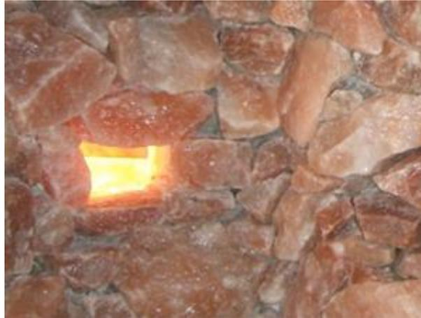
Revisionssteine sind wichtig, damit man die Glühbirne oder das Leuchtelement gut auswechseln kann. Man sollte unbedingt darauf achten, dass die Lampen Spritzwasser Geschütz sind, ebenso ist es zu empfehlen bei dieser Bauweise Erdkabel zu verwenden, da diese besser und stärker isoliert sind. Ebenso auf die Wahl der Leuchtfarbe, soll der Salzstein schön rötlich leuchten, sollte man warmweise Leuchtelemente verwenden.
