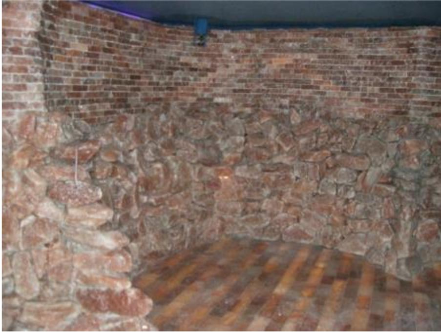
Hierbei wurden Salzziegel im Format 20x10x5 cm als Bodenbelag verwendet. Darüber Salzbrocken von 2 bis 25kg auf ca. 1,4m Höhe. Darüber Salzziegelsteine mit angerauter Oberfläche im Format 20x10x5cm quer verlegt. Um dies so zu erreichen und über den Salzbrocken noch eine glatte Ebene Fläche zu haben kann ich Ihnen empfehlen vorher die oberen Salzziegel auf Ytongsteine zu setzen, wie hier im Beispiel:
