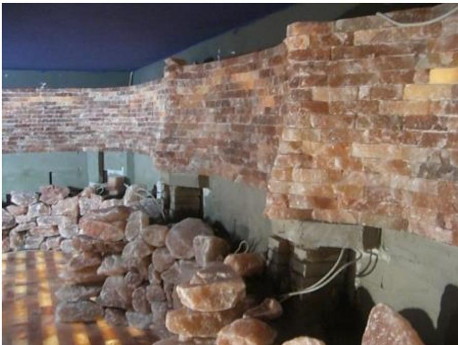
Die Salzbrocken wurden im hinteren teil mit Trass Zement vollflächig verklebt im Vorderenteil mit einem Natursteinkleber punktuell. Die Ytongsteine wurden mit einen Gewebekband und einem Feuchtraumputz verputzt.
